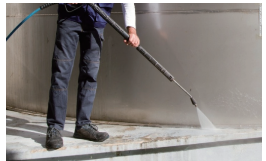
Очистка поверхностей от строительных загрязнений
