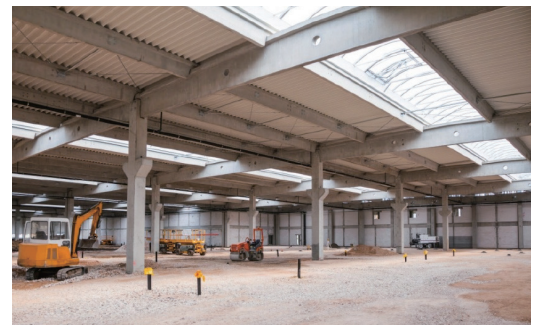
Санация бетонных сооружений
