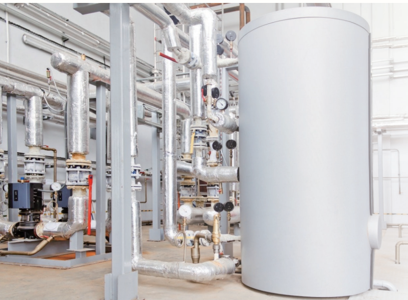
Очистка химического оборудования
